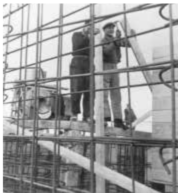
Construction d'un bunker sur l'Atlantikwall.
